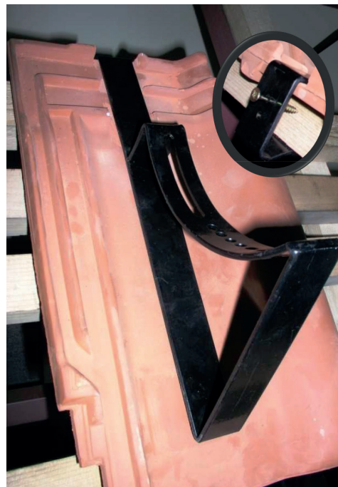
Fot. 1. Montaż wspornika ławy stopnia typu SHORT/LONG na dachówce ceramicznej
